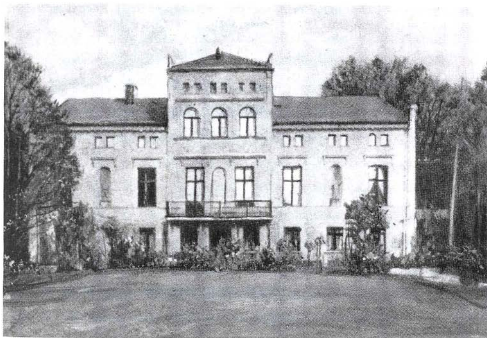
Gutshaus in Nippoglense
