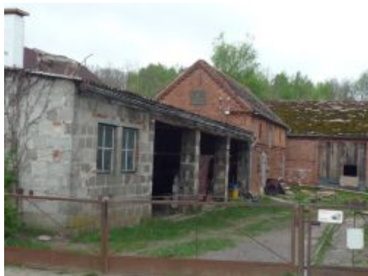
Hof von August Schmidt in Neu Flinkow
