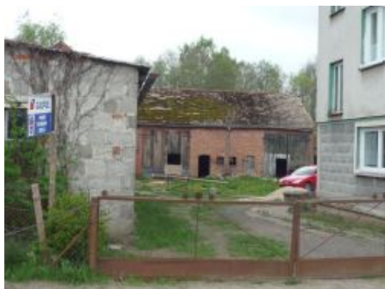
Hof von August Schmidt in Neu Flinkow
