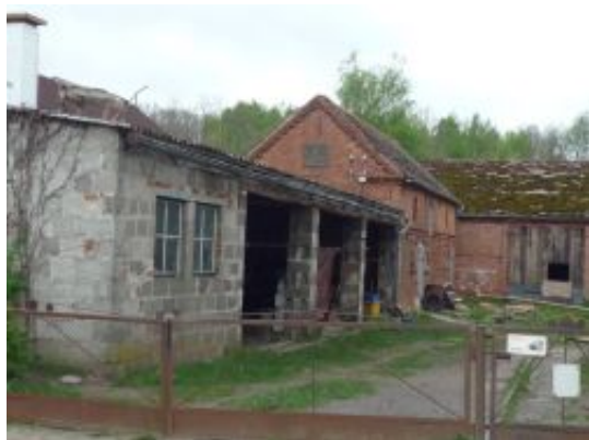
Hof von August Schmidt in Neu Flinkow
