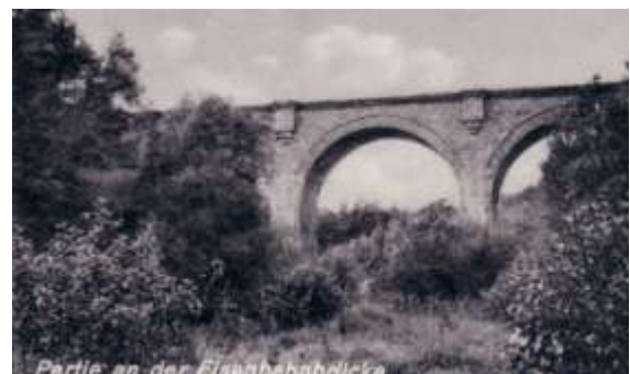
Eisenbahnbrücke bei Wutzkow
