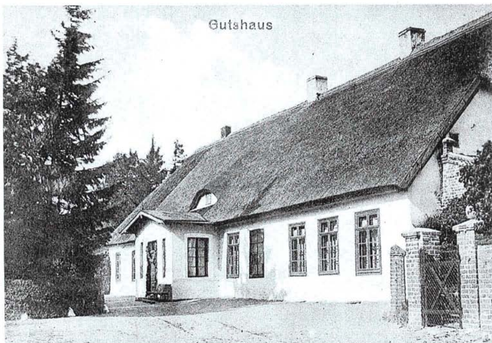
Gutshaus in Giesebitz
