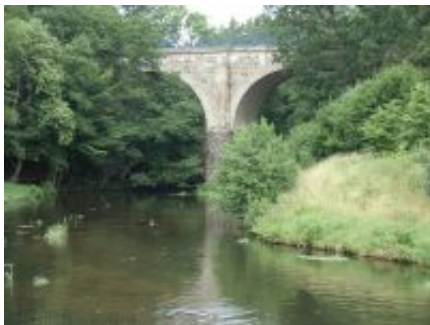
Eisenbahn-Viadukt, Foto 2005 Wilfried Wegner
