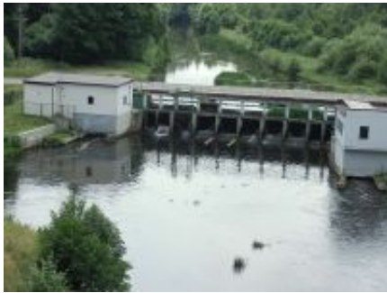
Blick auf die Schleusen, Foto 2005 Wilfried Wegner
