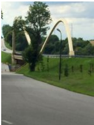
Die neue Lupowbrücke 2017
