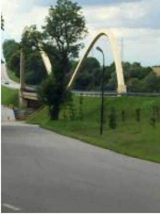
• Die neue Lupowbrücke 2017
