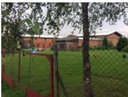
Haus Nr. 13 Hofanlage
